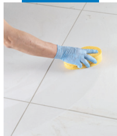
Окончательная очистка плитки с помощью целлюлозной губки
